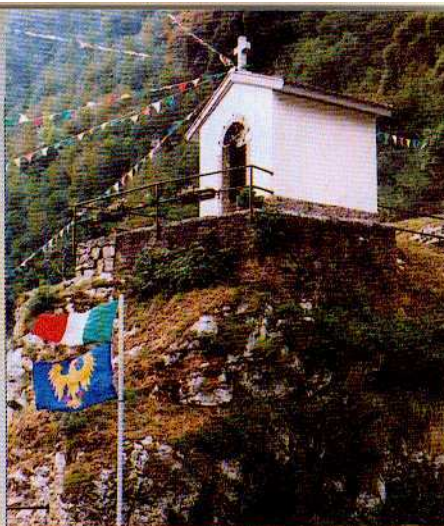
La chiesetta ristrutturata dagli alpini.
