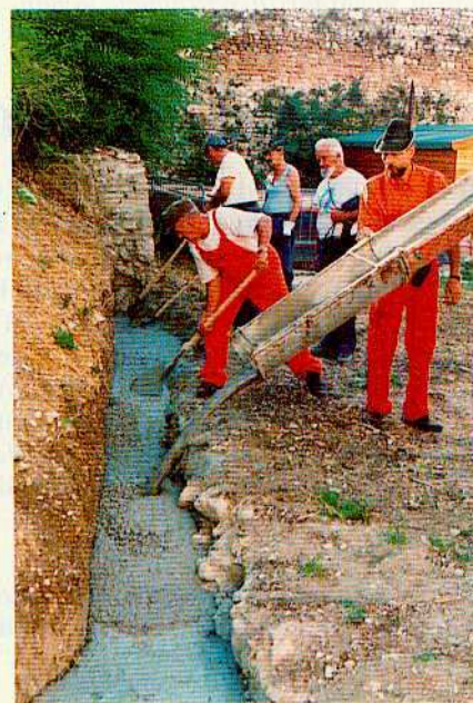
Volontari della PC della sezione di Milano all'opera per costruire la recinzione di una scuola.
