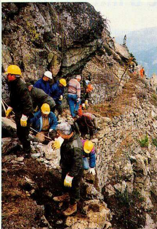
Volontari alpini al lavoro in uno dei sentieri di Clavière distrutto dall'alluvione del '91.
