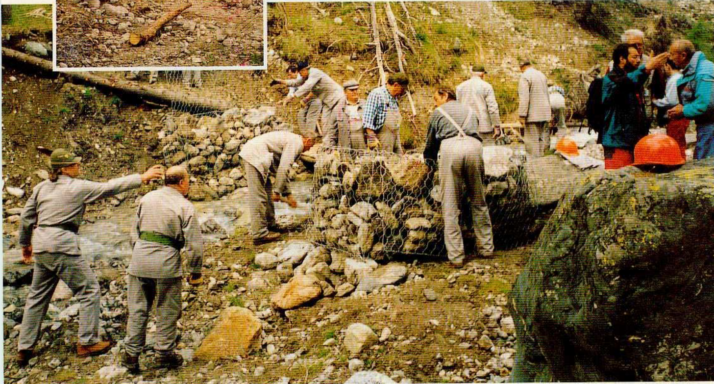
Si costruisce una massicciata. Nella foto sopra: la scalinata che parte dal greto del torrente, verso lo Chaberton.
