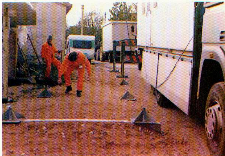
Si prepara la piazzola per un container
