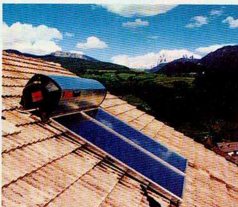
Montaggio serbatoio sopra tetto
