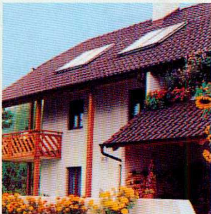
Montaggio serbatoio sottotetto
