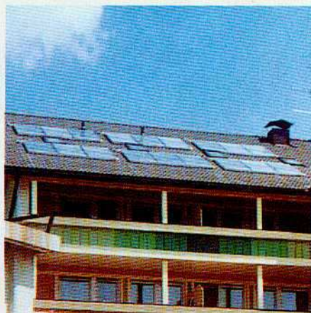
Sistema multiplo con serbatoi sottotetto per alberghi
