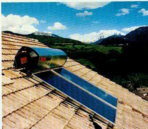
Montaggio serbatoio sopratetto
