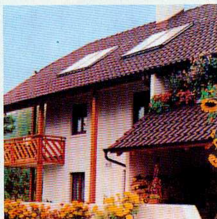
Montaggio serbatoio sottotetto
