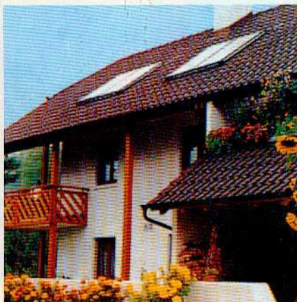
Montaggio serbatoio sotto tetto
