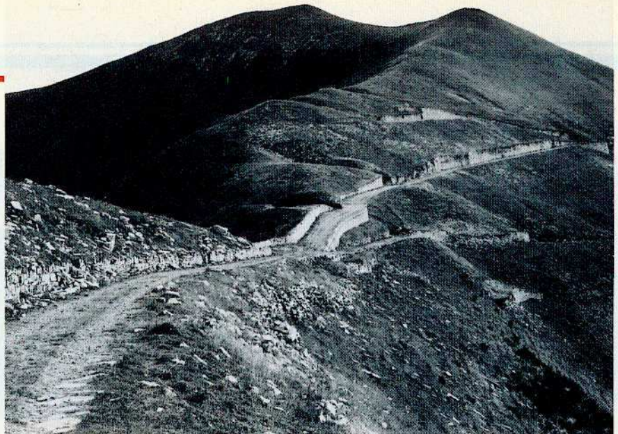
Strada d'arrocamento sui monti della Tremezzina (sulla sinistra sono visibili gli avvalamenti in due postazioni di artiglieria)
