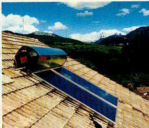
Montaggio serbatoio sopra tetto
