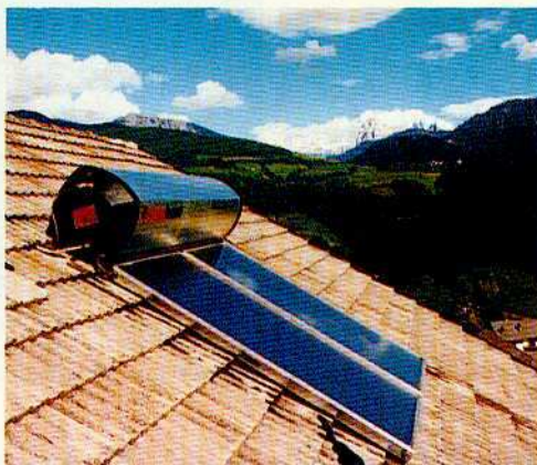
Montaggio serbatoio sopratetto
