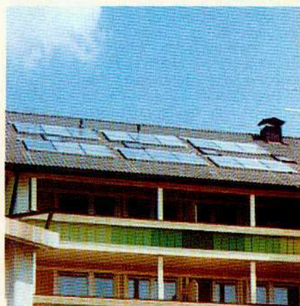
Sistema multiplo con serbatoi sottotetto per alberghi
