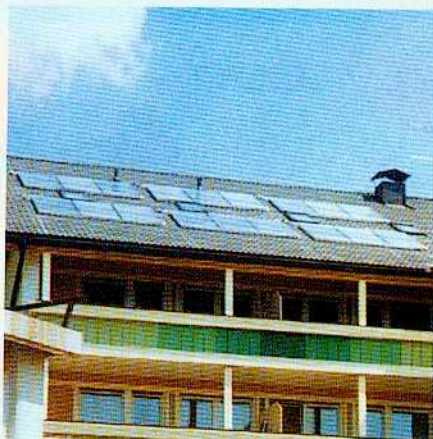
Sistema multiplo con serbatoi sottotetto per alberghi
