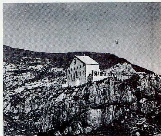
Foto storica della prima ala sul lato sud del rifugio Cazzaniga - Merlini
