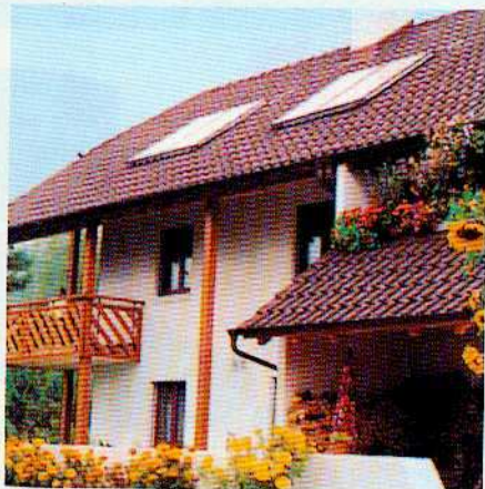
Montaggio serbatoio sottotetto
