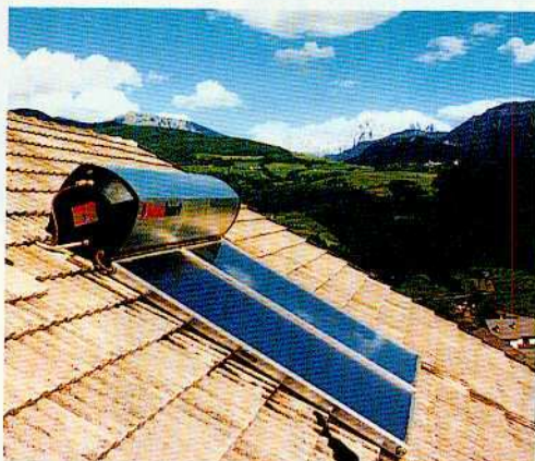
Montaggio serbatoio sopratetto
