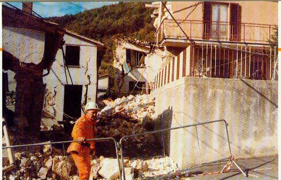
Annifo: un alpino della Protezione civile transenna alcune case distrutte
