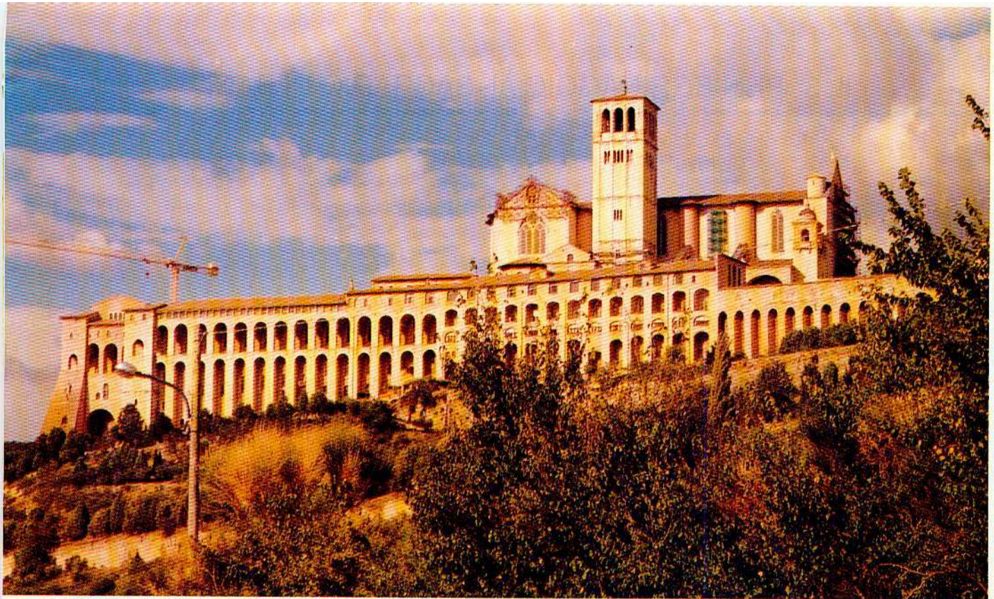
Il convento francescano di Assisi. Da notare l'armatura che sorregge il timpano del transetto della basilica superiore di San Francesco
