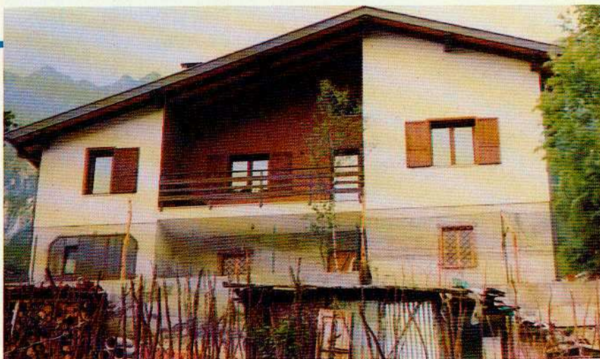
La Casetta di Cornappo, costruita dalla sezione per un socio terremotato con il concorso della sezione Venezuela
