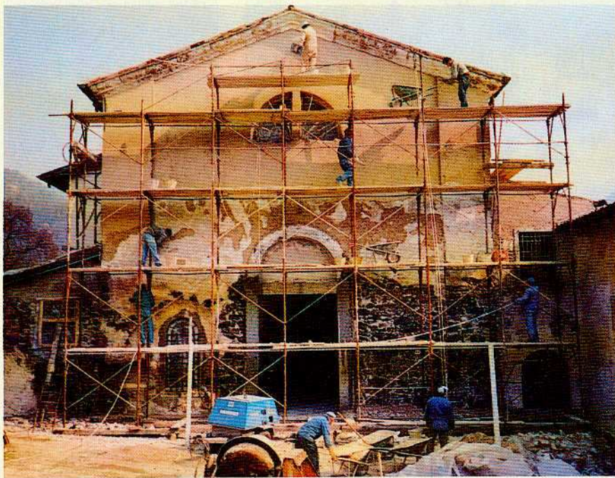
I lavori di restauro della chiesa, con intonacatura della facciata
