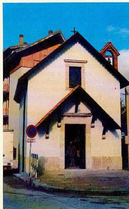
Roccaraso: la chiesa di S. Bernardino restaurata dal gruppo A.N.A.
