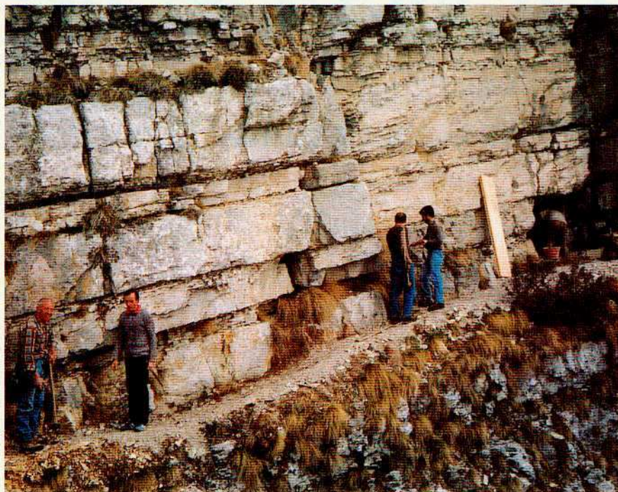
Lavori di ripristino sulla cengia dell'uscita della galleria centrale.
