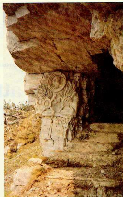
L'ingresso alla galleria centrale con le insegne delle compagnie del genio militare che fecero i lavori di scavo.
