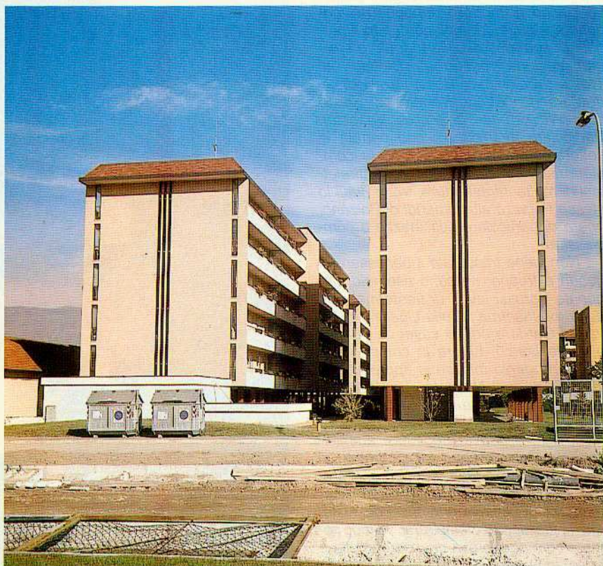
Modernissimo complesso di 120 alloggi per ufficiali e sottufficiali, realizzato in Bolzano in tre lotti d'appalto, da 1981 al 1986.
