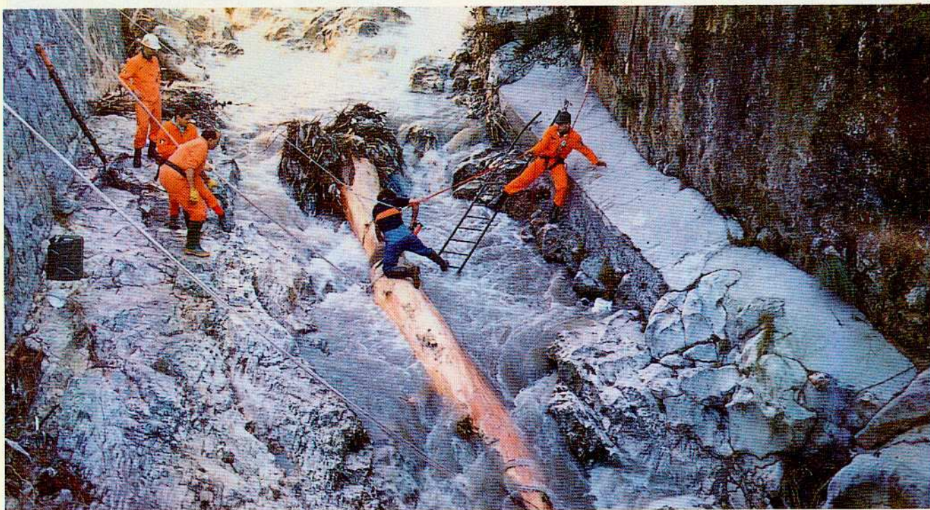
Si provvede allo sgombero dell'alveo del Garza da detriti, rami, plastica e persino grossi tronchi travolti dall'alluvione.
