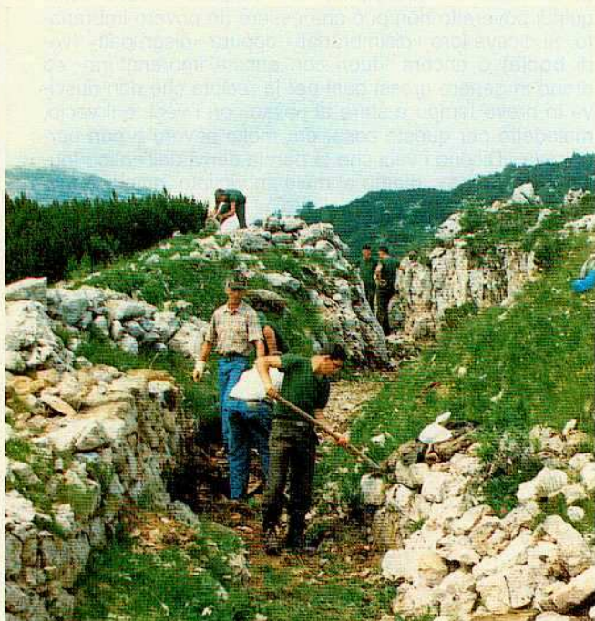
Svuotamento di una trincea
