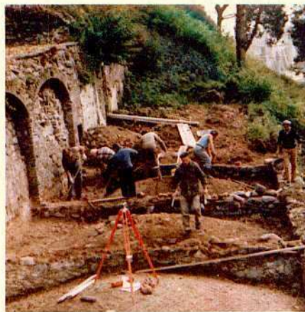
Sistemazione di un terrapieno a Sagliano
