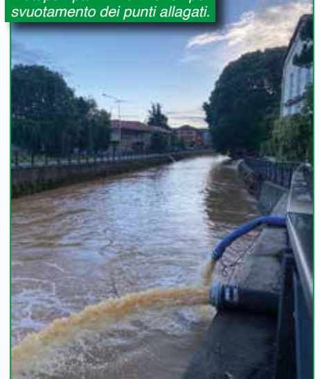
Motopompa in funzione per svuotamento dei punti allagati.
