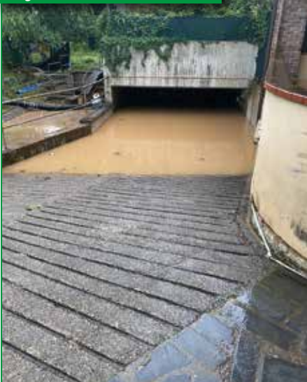
Allagamento di una autorimessa.
