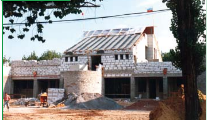
Giugno 1992 - Stato di avanzamento lavori
