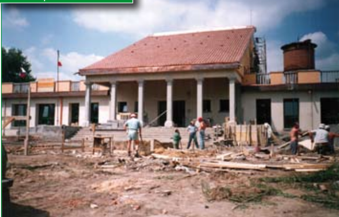
Luglio 1993 - La costruzione dell'Asilo procede veloce
